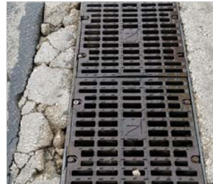
Installazione canaletta senza bordo
