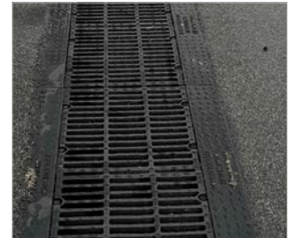
Installazione canaletta con bordo
